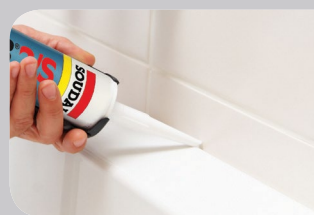
Sanitaire voegen Application sanitaire
